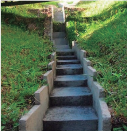
Ilustración 15. Disipadores de energía
