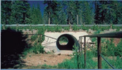
Ilustración 13. Alcantarillas
