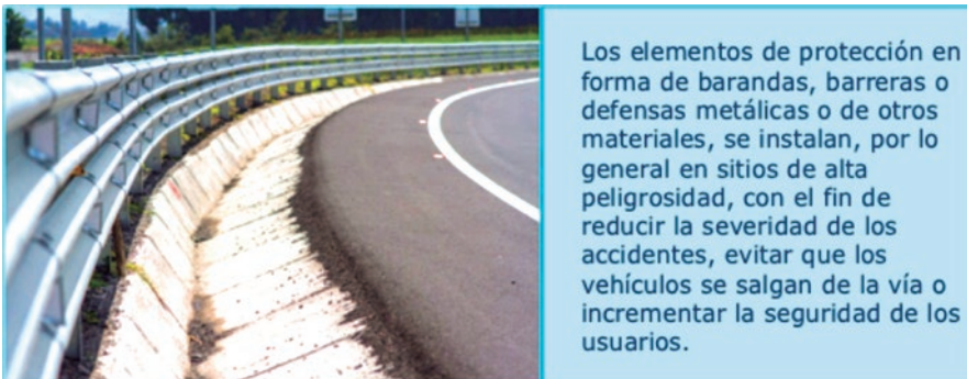
Ilustración 21. Barandas de protección
