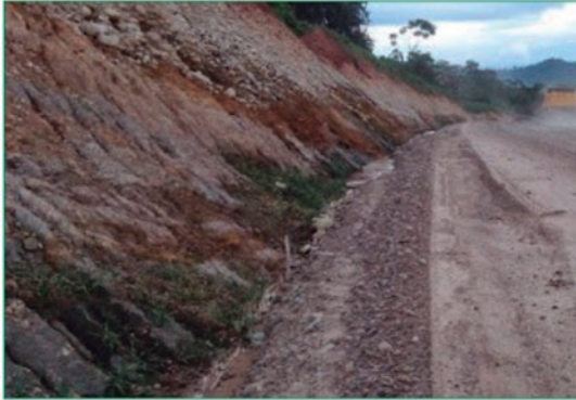
Cuneta sin revestir
